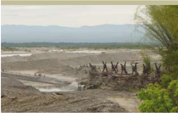
Figura 2.32 Río Pescado, espigón combinado de pie de gallo y gaviones, en crecida, 2006
