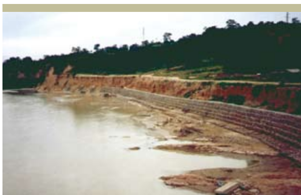
Figura 3.48 Muro marginal de gaviones, margen izquierda río Bermejo, 1994
