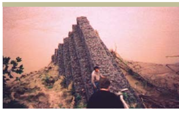
Figura 3.53 Espigón de gaviones margen izquierda río Bermejo en El Colorado, 1994
