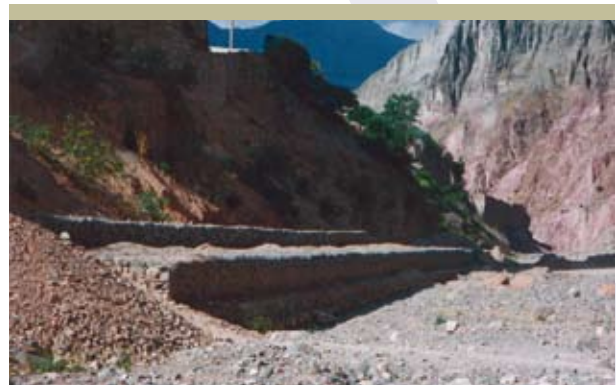
Figura 2.36 Río Colanzulí, muro longitudinal de gaviones
