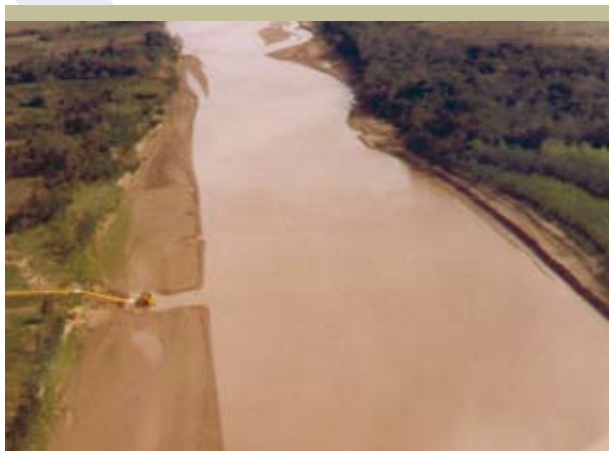
Figura 3.61 Toma de agua Don Panos margen derecha río Bermejo en aguas bajas.
