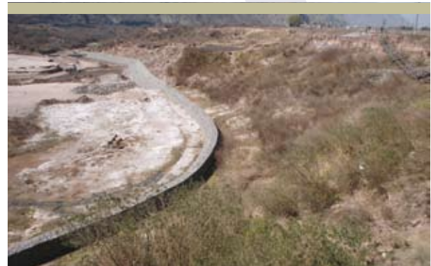
Figura 2.27 Río Grande de Jujuy, muro marginal de gaviones, 2007
