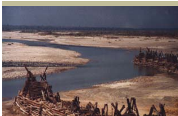
Figura 2.23 Espigones en el río Pescado, 1987
