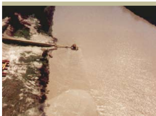
Figura 3.62 Toma de agua Don Panos margen derecha río Bermejo en aguas altas.
