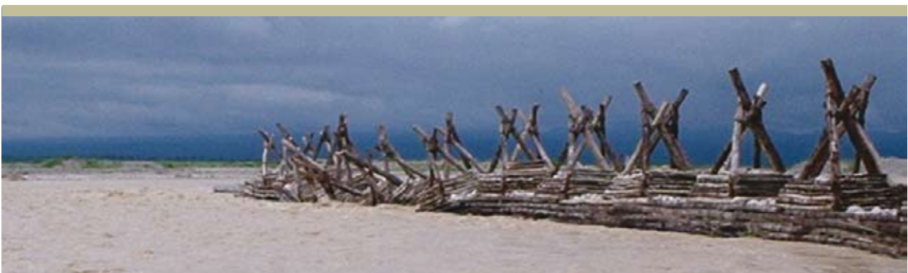
Figura 2.34 Río Pescado, espigón de pie de gallo y gaviones, 2006
