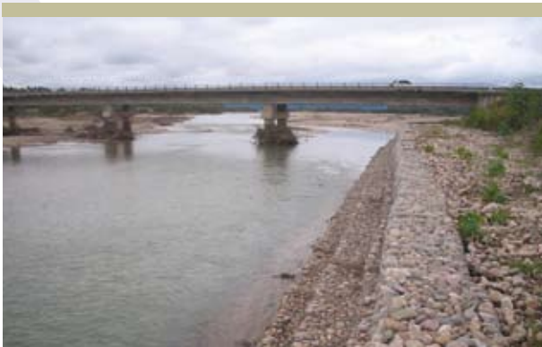
Figura 2.30 Río Blanco, muro encauzamiento, puente ruta 50, 2007
