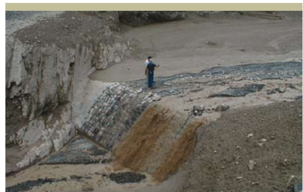
Figura 2.28 Control del lecho del río Colanzulí, Iruya
