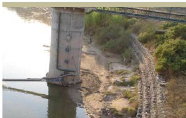
Figura 3.52 Muro marginal de gaviones, margen izquierda río Bermejo, 2007
