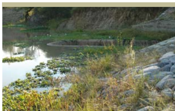
Figura 2.25 Río Mena, diques de tierra para retención de sedimentos, Bolivia
