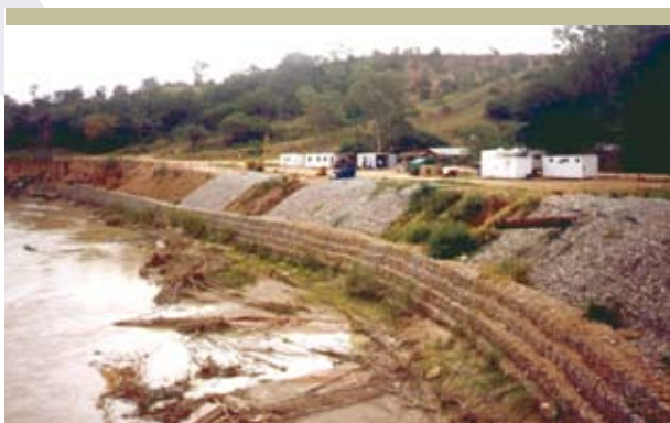
Figura 3.49 Muro marginal de gaviones, margen izquierda río Bermejo, 1988
