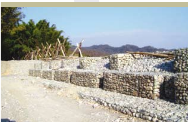
Figura 2.31 Río Pescado, espigón combinado de pie de gallo y gaviones, 2006
