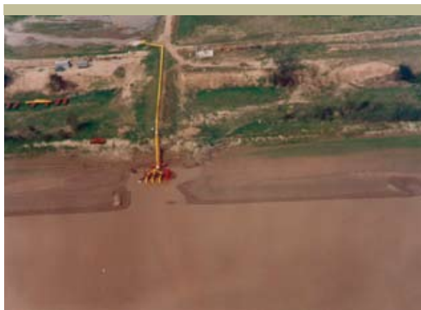
Figura 3.60 Toma de agua Don Panos margen derecha río Bermejo, provincia de Chaco
