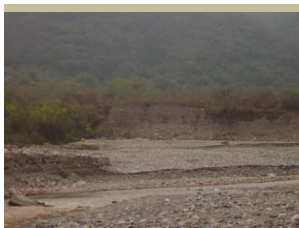
Figura 2.50 Vistas de la zona de aguas abajo del dique Los Molinos
