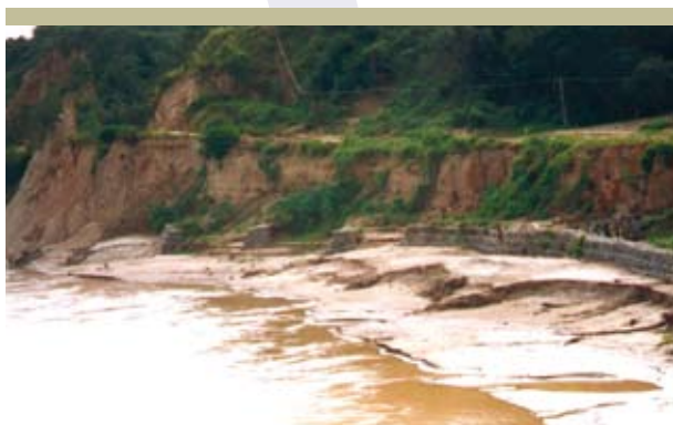
Figura 3.50 Muro marginal de gaviones, margen izquierda río Bermejo, 2000
